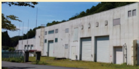
電気の受変電設備が入っている共通施設棟の耐震改修設計
