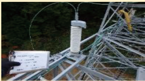
特高受変電設備避雷器更新
